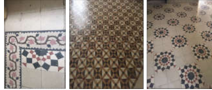
صورة (13): توضح أرضيات الفراغات الداخلية لبيت طوقان من بلاط المزابيكو من تصوير الباحثين 11 Oct 2022
