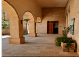
صورة (11): توضح سماكة الجدران الخارجية للطابق الأرضي لبيت طوقان من تصوير الباحثين 11 Oct 2022
