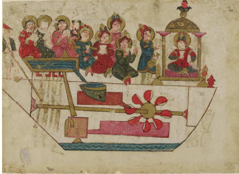
شكل رقم (2): ميكانيكية المركب من الداخل كما صورها الجزري في كتابه "الجامع بين العلم والعمل النافع في صناعة الحيل" الذي أنتهى منه المؤلف عام 1206 (الحسن، 1979: 439)
